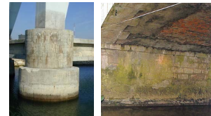
Photos 5 et 6 : Dégradations des ouvrages d'art (1)
